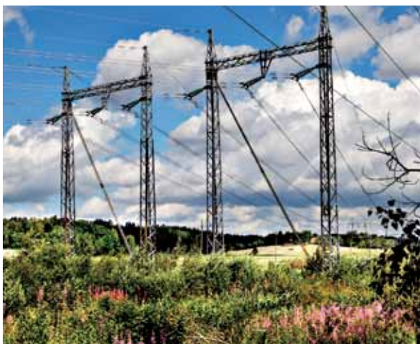
Harustettu kaksijalkainen teräspylvä
