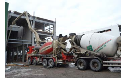
Betonin siirto valukohteeseen kuljetuspumppuautolla, johon lisätään massaa tavallisesta pyörintäsäiliöautosta (kuva Tarja Merikallio).
