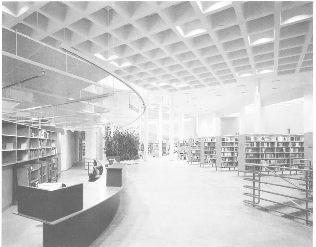
Kuva 9. Joensuun kirjastotalo, Tuomo Siitonen ja Tuomas Wichmann, 1992. Rationaalisena rakenteena paikallavalettu kuppilaatasto samanaikaisesti luo arkkitehtonisesti arvokkaan tunnelman.
