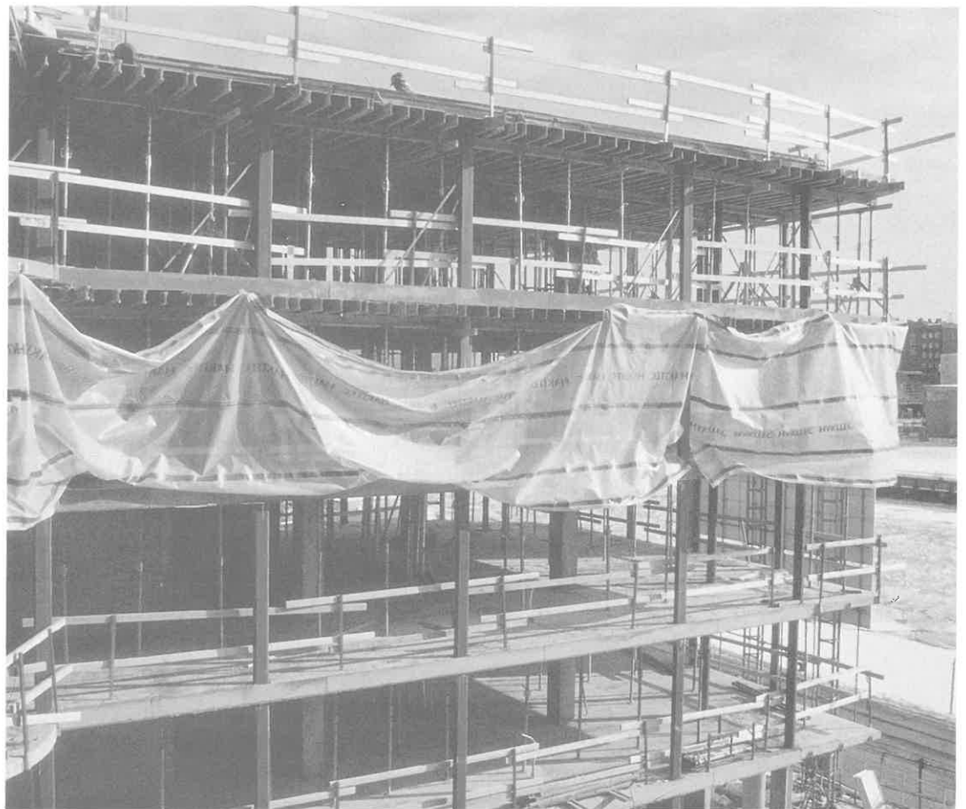
Kuva 13. Tysta huset, "Hiljainen talo" Tukholmassa on asuinkerrostalo, jonka ääneneristävyttä parannettiin huomattavasti valitsemalla runkojärjestelmäksi pilarilaattarakenne ja väliseiniksi useampikerroksiset erillsrunkoiset levyseinät.
