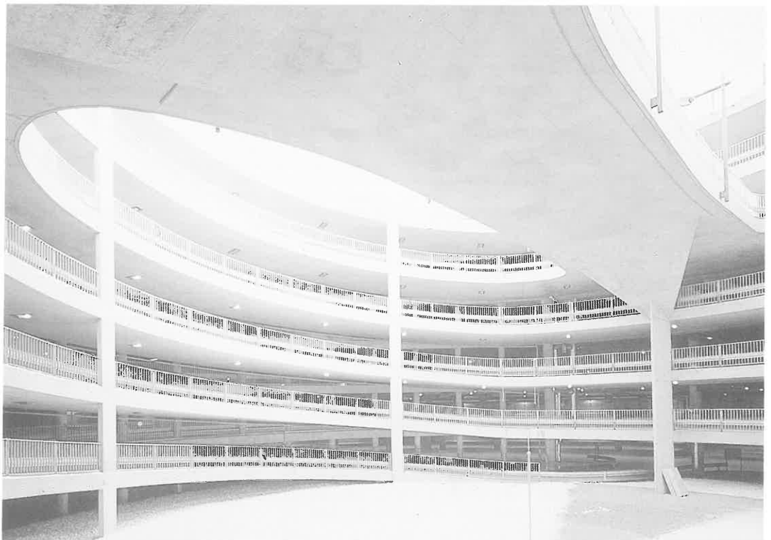
Kuva 105. Helsinki-Vantaan lentoaseman pysäköintilaitos.
