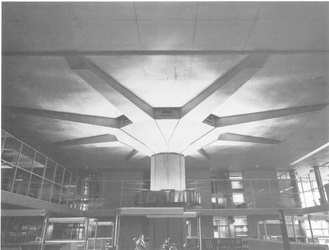
Kuva 12. Paikallavalettu laattarakenne on monoliittinen ja saumaton.
