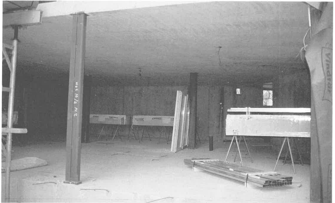
Kuva 62. Täydentävien pilareiden käyttö kantavien seinien välillä. Esimerkki ruotsalaisesta asuntokohteesta.
